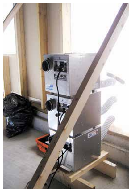
Rotoravfuktere i bruk på en av Trysilhus' byggeplasser. (Foto: F-Tech)
