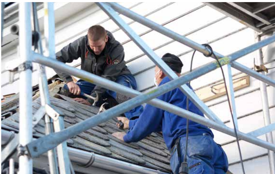
– Skiferen er enkel å legge, men vi må jo følge med så det blir korrekt, sier Harald Strand (t.v.) og Svein Nordal fra Faber Bygg.
