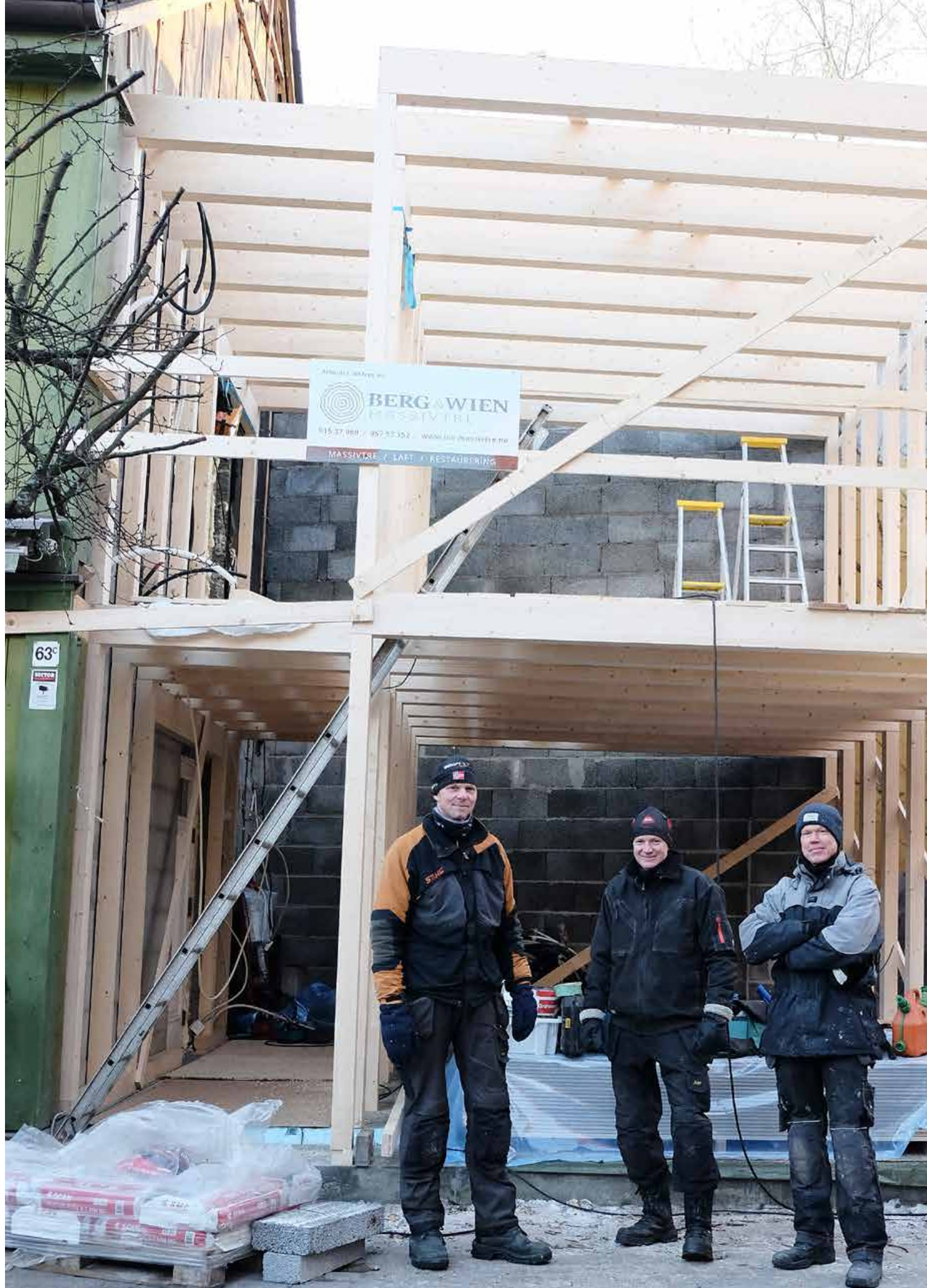
(F.v.) Tømrermester Lars Kristian Wien og tømrer Emil Lilleengen Haug fra Berg & Wien reiser konstruksjonen, med tømrer Andreas Melby fra byggmester Egil Norli som skal fullføre tilbygget.
