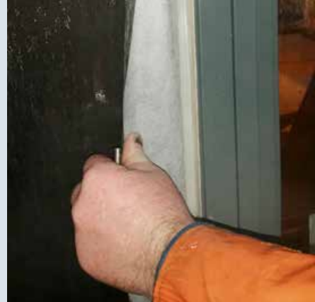
Vindsperreremsa fuges og klemmes mot karmen.
