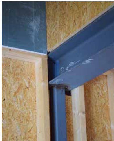
Stålsøyler og dragarar skal stive opp fasaden, og det vart ein jobb å få dei til å passe med trekonstruksjonen.
