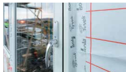
Det tapes og tettes forsvarlig rundt dører og vinduer.
