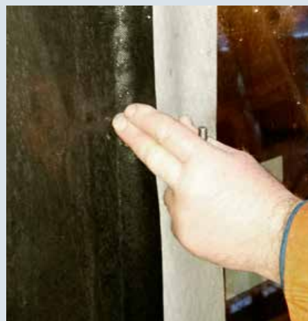
Når vindsperreremsa er festet, blir lag vindsperrerduk klemt til karmen. (Foto: Halbjørn Sundgot)
