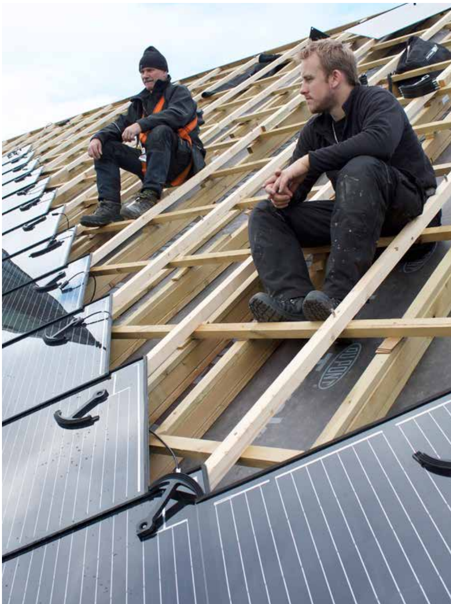
John Kåre Haaland (t.v.) og Ørjan Thomsen fra Byggmester J.K. Haaland AS, ble leid inn for å legge solcellepanelene.
