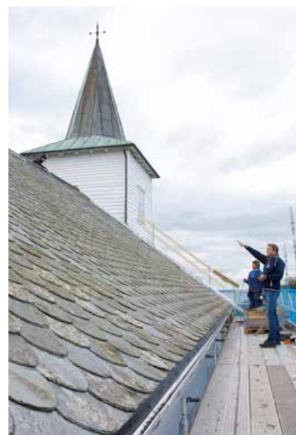
Den opprinnelige skiferen er lagt tilbake på det nordvendte taket.
