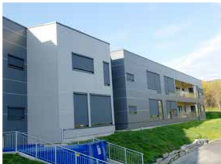
Et tilbygg på 1.500 m 2 til Hansnes sykehjem ble overlevert for ett års tid siden.
