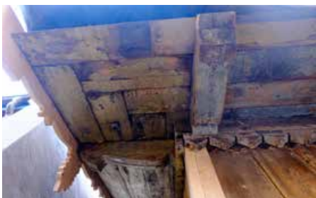
Tandberg har bevart så mye av de originale bygningsdelene som mulig.
