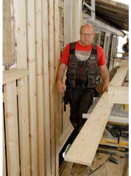
Tømmer Harald Hørte legger kledning på veggen mot gata. Legg merke til den skjeve veggen bak ham.
