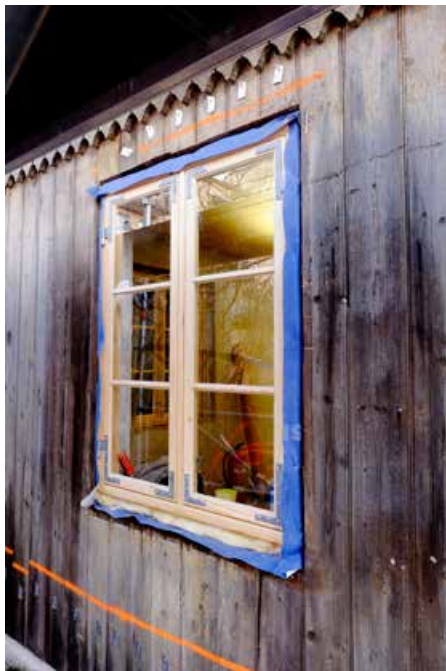
For å bevare konstruksjonen, ble det valgt å isolere med 15 mm aerogel kalkmørtel. Det tynne laget tilsvarer 60 - 100 mm isolasjon utenpå det utmurte bindingsverket.
