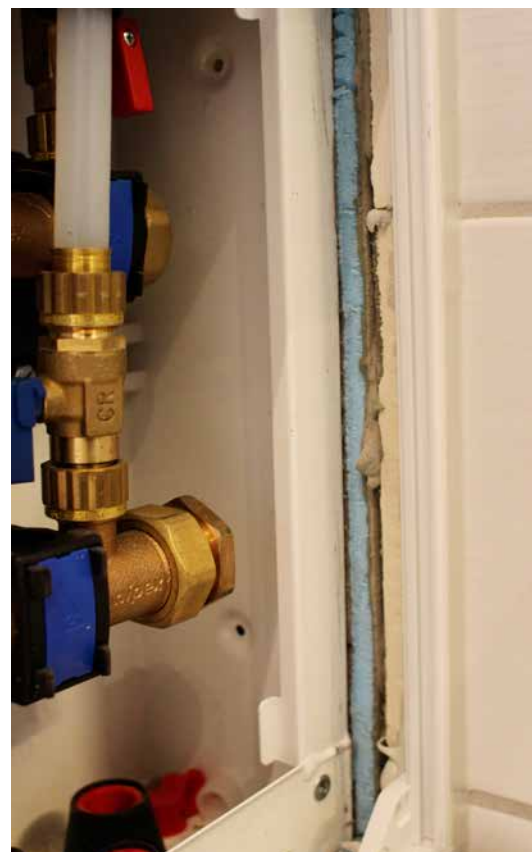
Skjult anlegg og rørføring - Roth rør i rør system.
