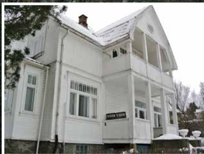
Fasade nord før rehabilitering.
