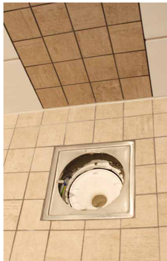
Det ble benyttet VSK godkjent Purus Joti gulvsluk i trebjelkelag.
