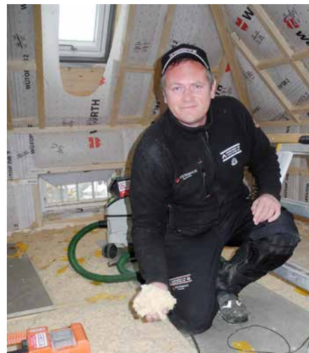
Trefiberisolasjon er valgt i vegger, tak og etasjeskiller, viser Tom Andreassen.
