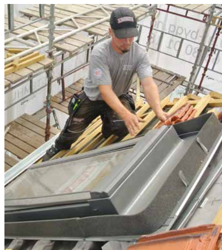
Mye å passe på når takvinduer monteres.
