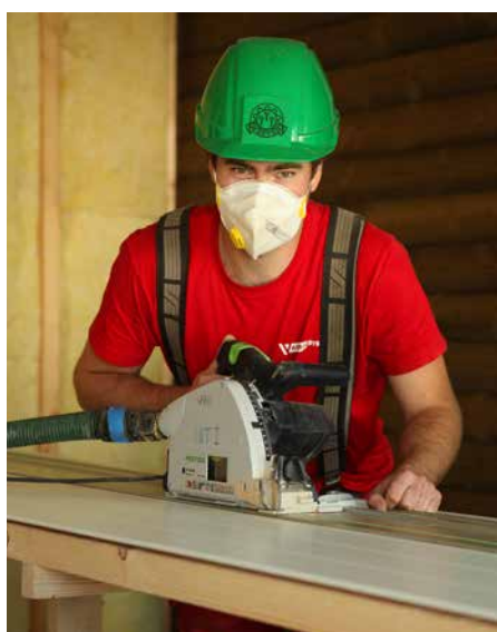
Ørjan Grindberg driver mest med innvendige arbeider.
